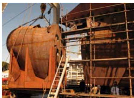
Postavljanje novo izrađenog "bulp"-a na pramac M/T "Marca Pola"
