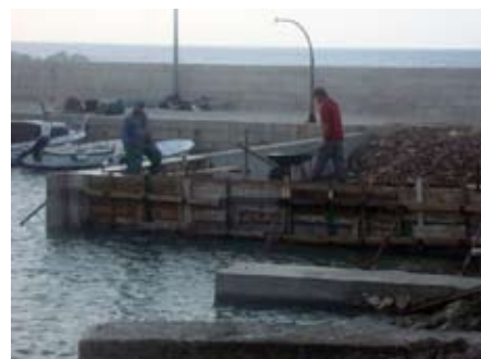
Radovi pristaništa na Unijama
