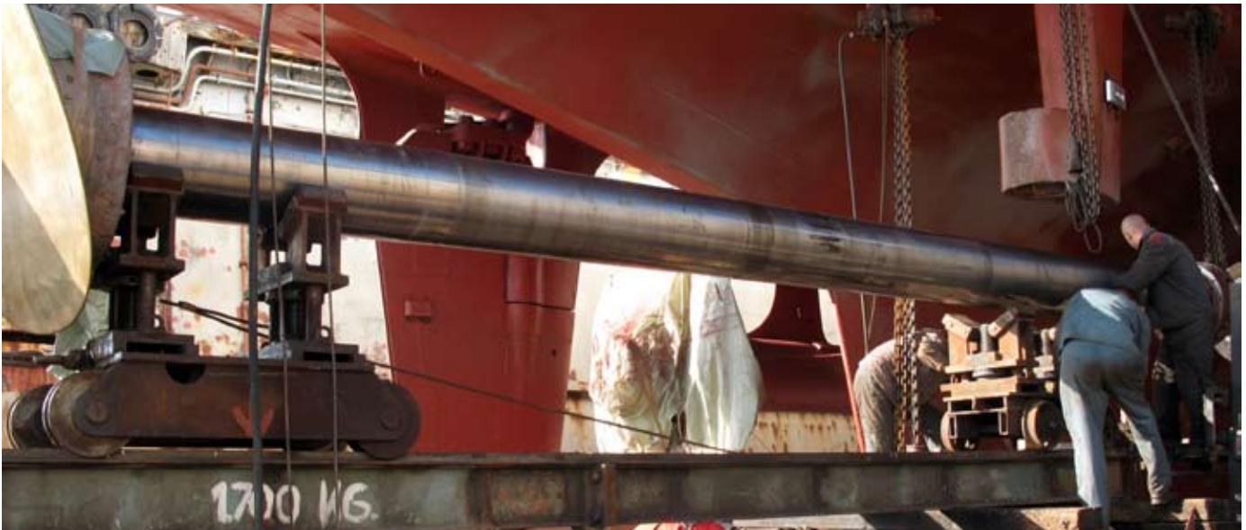
Postavljanje dugačke osovine propelara pomoću nosivih saonica
